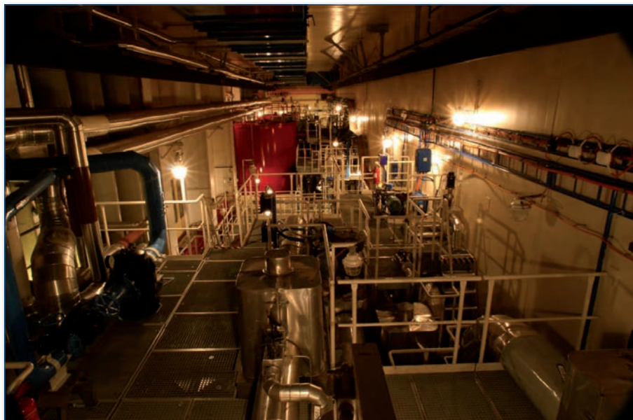
Snížení vibrací potrubí přívodu páry k PSA v A820
